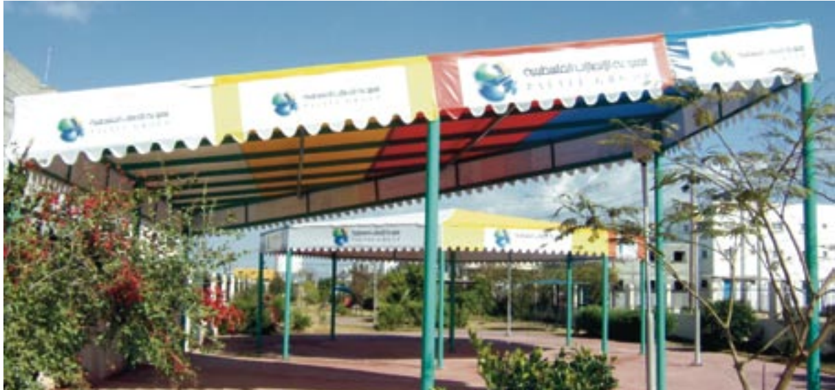
مشروع تركيب مظلات في حديقة بلدية الخازي - غزة
